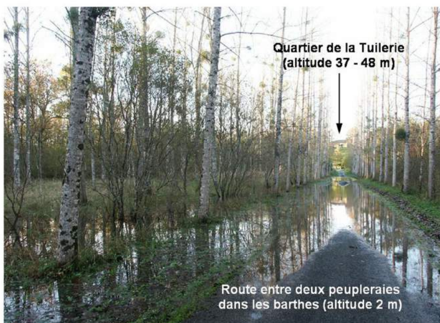
Inondations hivernales de la Barthe basse. Ici sur la RD 362 au pied du quartier de la Tuilerie
