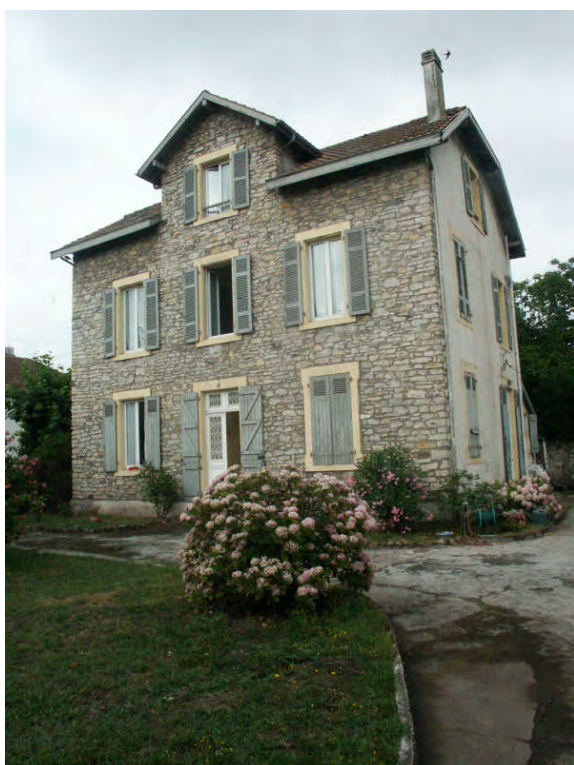
Les maçonneries, constituées de moellons, sont destinées à être enduites. Les encadrements de pierres sont généralement disposés en surépaisseur du moellon de manière à permettre à la couche d'enduit de venir au nu de l'encadrement ou en très léger retrait.
