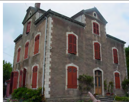
Volet sur une villa des ingénieurs
