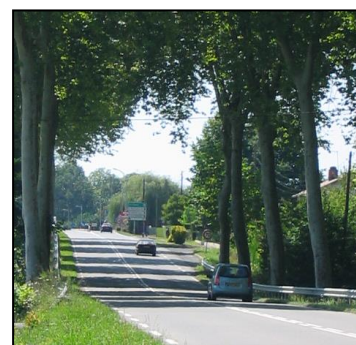
③ Entrée Est (RN 117)
