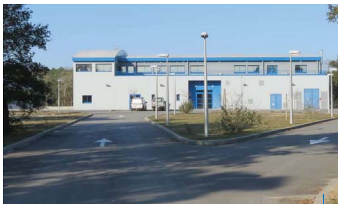
la station de traitement d'eau potable à Ondres Sources : commune de Ondres
