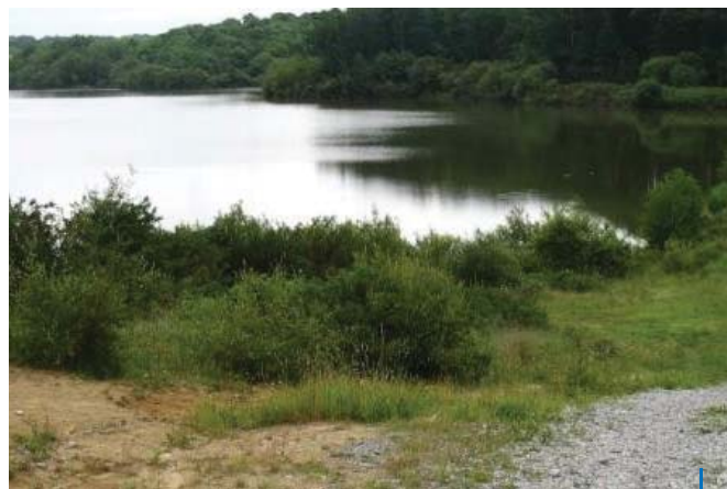
Barrage de la retenue d'eau de Bédorède
