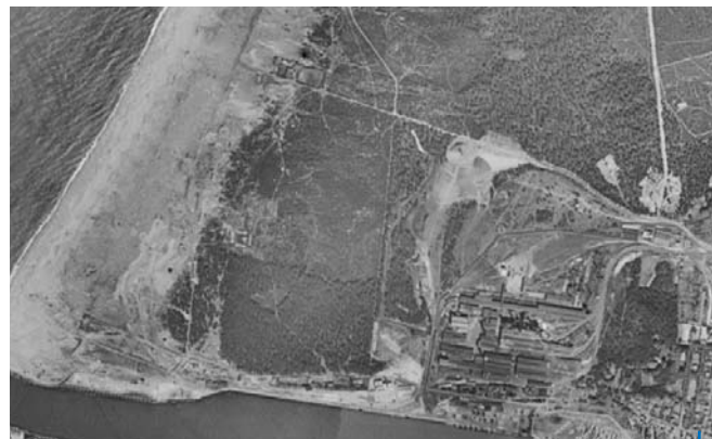
Situation entre 1950-1965 : fermeture des Forges de l'Adour Source : IGN
